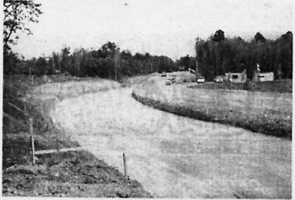
工事中の公園進入道路
